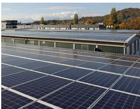
Montering på tak i vinkel gör det enklare att ta tillvara på solenergin.
